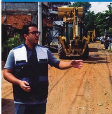
Obras de infraestrutura Mais qualidade de vida
